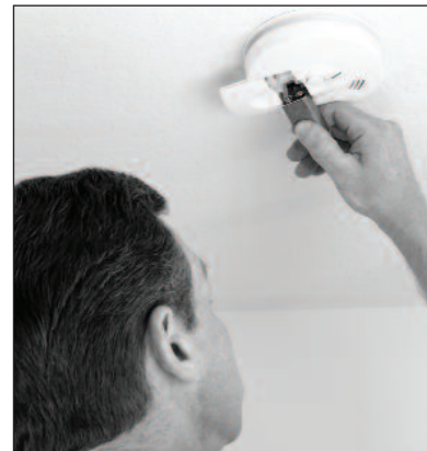
Να τοποθετήσουν ανιχνευτές φωτιάς σε κάθε δωμάτιο και να μην ξεχνούν να κάνουν τακτικό έλεγχο των μπαταριών
